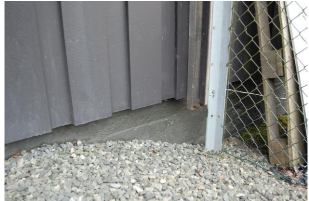
Figur 4. Grønnmalt betong på grunnmur utvendig.
