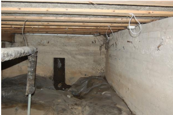
Figur 3. Ubehandlet grunnmur, ringmur og fundamenter.
